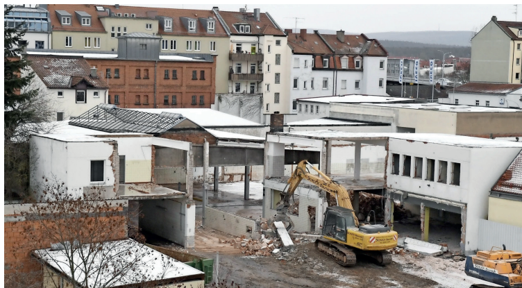
Der Abbruch des ehemaligen Moosmaier-Areals ist inzwischen abgeschlossen (Bild oben). Das untere Bild zeigt die Abrissarbeiten zu einem früheren Zeitpunkt. Die Fläche soll nun entsiegelt werden. Fotos: Ronald Rinkler
